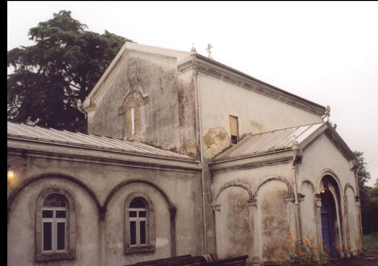
ხედი სამხრეთ-დასავლეთიდან გადაკეთებამდე view from south-west until reconstruction
